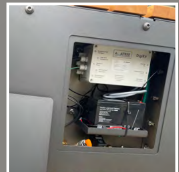
Steuereinheit (optional) im Trockenbereich der HUNO® Tankbank zur digitalen Ventilsteuerung
