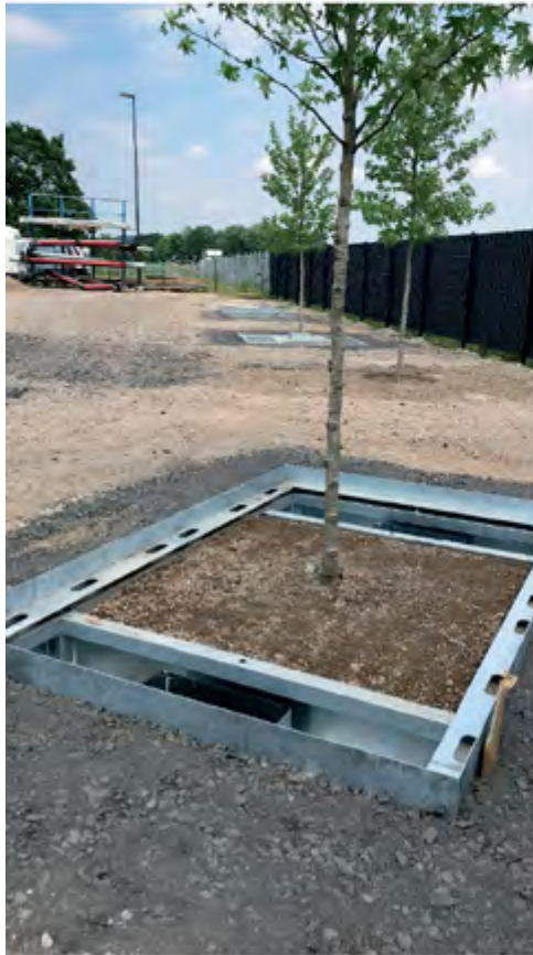
Abb. 2a: Ausführung der Baumrigole | Foto: Grüning, FH Münster
