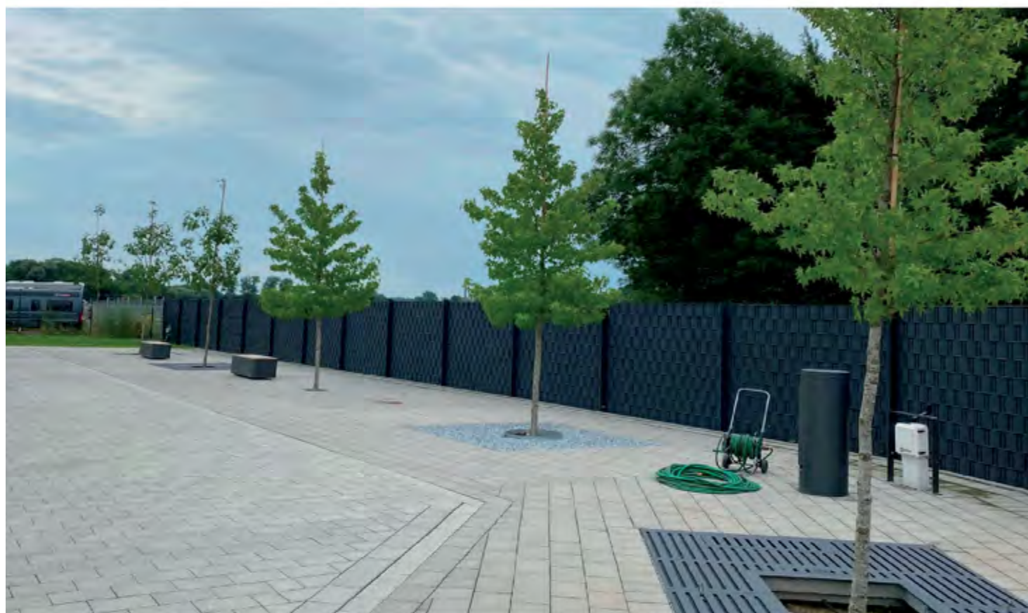
Abb. 3: Baumrigolen nach dem Einbau | Foto: Grüning, FH Münster
